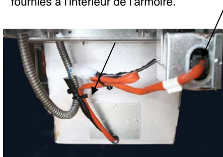
Figure 3 : Fixez les connecteurs blancs à deux broches et branchez le connecteur noir au coffret de prise de courant ainsi que montré.
